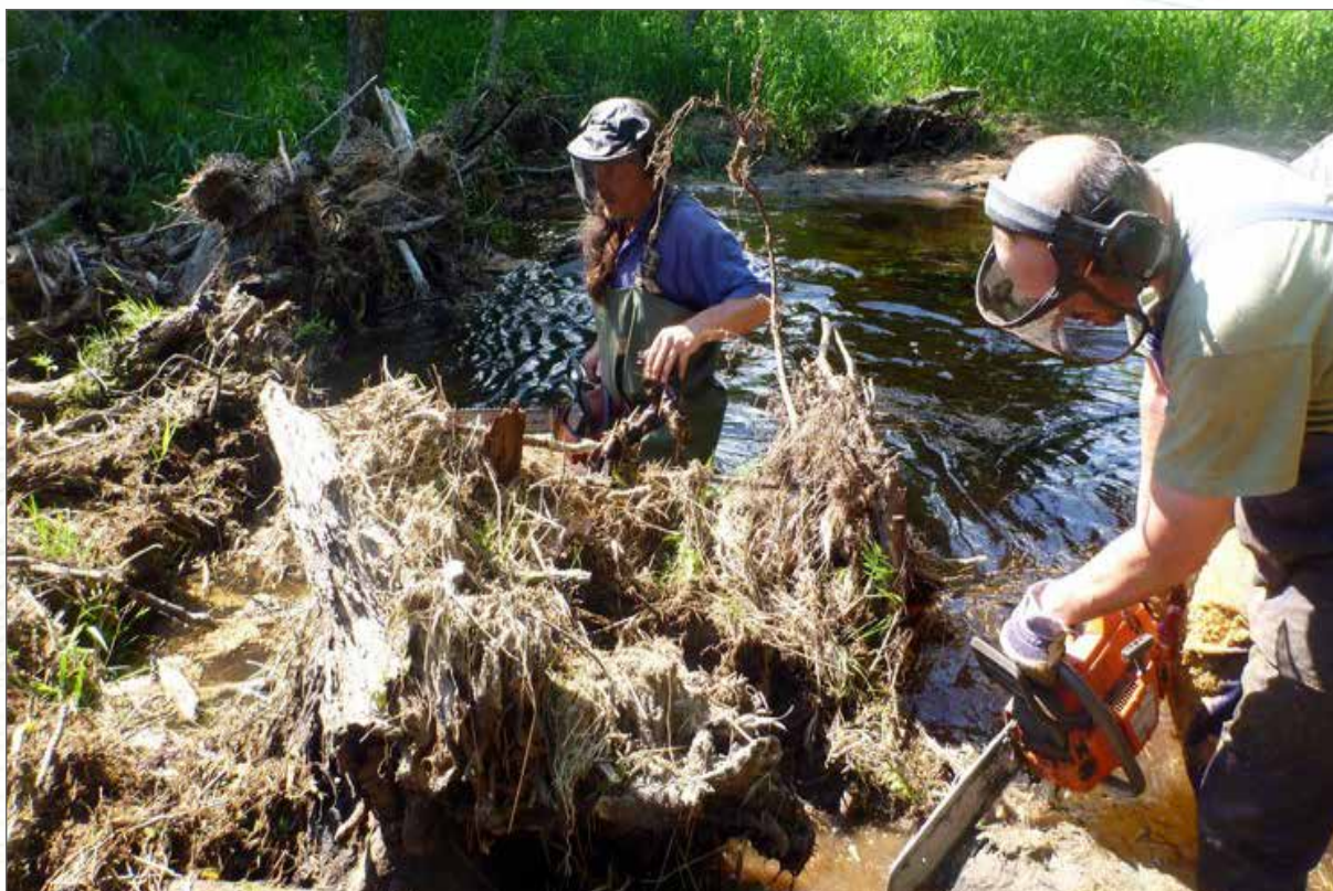
Obr. 156a. Příklad zprůchodňování vodotečí. Odstraňování zátarasu, ohrožujícího cenný meandr nad Odchovnou Spálenec.
