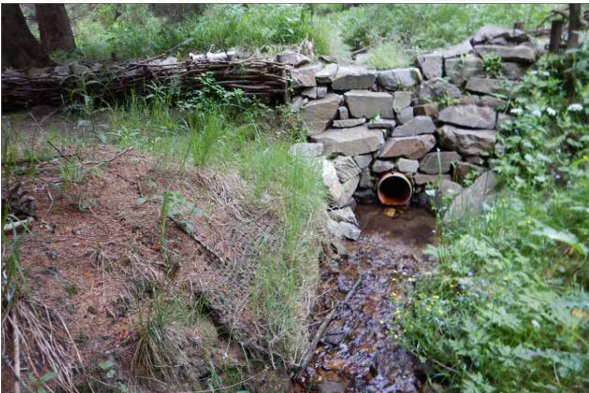
Obr. 147d. Podobné místo jako na Obr. 147a po průchodu několika povodní (po kterých následovalo vyčištění okolí trubky) a zapojení vegetace.
