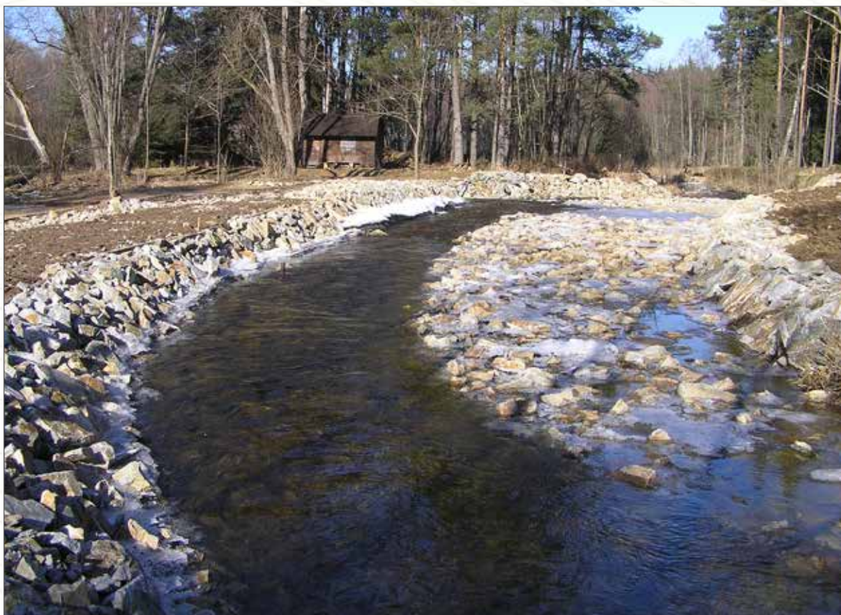
Obr. 155. Opevnění meandru z lomového kamene, provedené při nutné stabilizaci břehu nad příčným stupněm zavodňujícím boční rameno v místě ORP Odchovna Spálenec.
