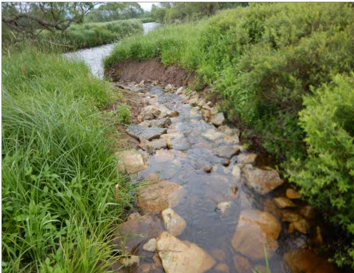
Obr. 136. Strmé ústí Žlebského potoka do Teplé Vltavy. Koryto zde bylo vymodelováno a zpevněno kameny, na rozdíl od ploché nivy, kde byl vodě ponechán prostor pro samovolné dotváření koryta.
