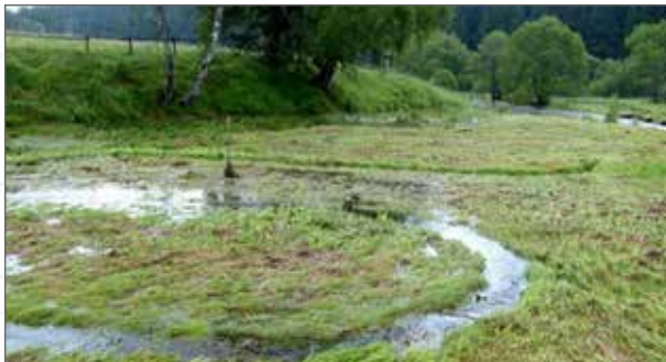
Obr. 26. Odchovný a reprodukční prvek na Spáleneckém potoce v nivě Blanice po přeplavení celé nivy povodní s desetiletou extremitou. V ploché nivě s možností rozlivu Blanice nedošlo k mechanickému poškození ani zanesení ORP sedimenty.
