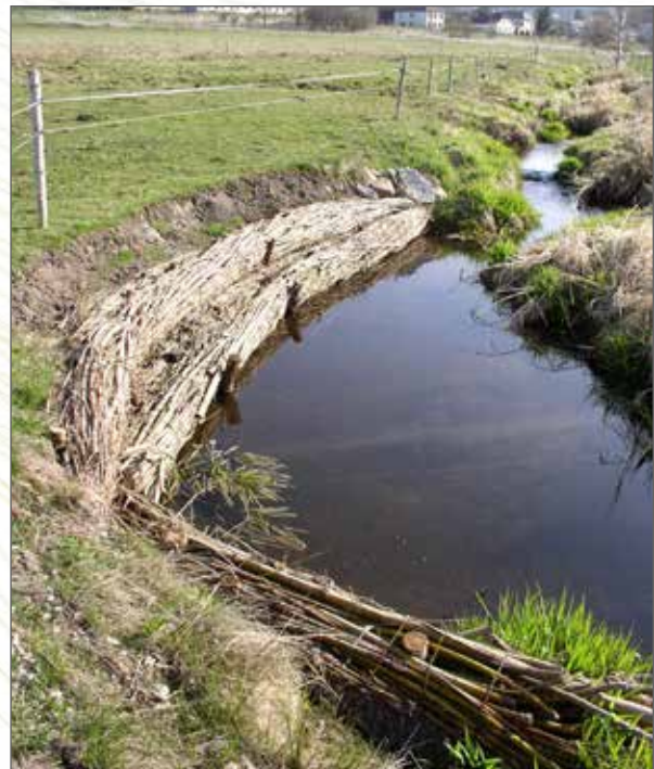
Obr. 151c. Metrová postupující eroze stabilizovaná haťošterkovým oživeným válcem v listopadu 2006.
