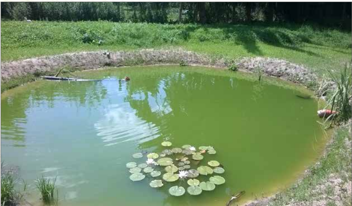
Obr. 83b. Totožná první nádrž série druhý rok po založení, kdy se postupně rozvíjí mokřadní vegetace a vegetační zákal způsobený jednobuněčnými řasami, které zlepšují dočišťování.
