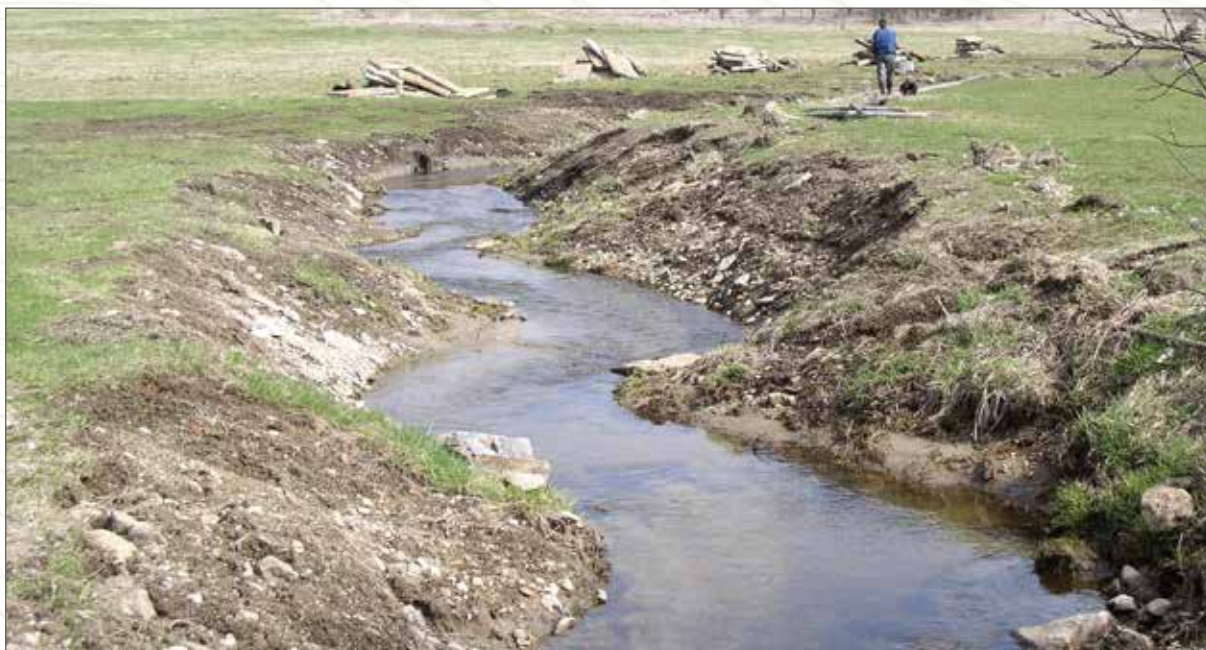
Obr. 194b. V listopadu 2004 byla provedena částečná revitalizace koryta – vytrhání betonového opevnění a naznačení meandrů.
