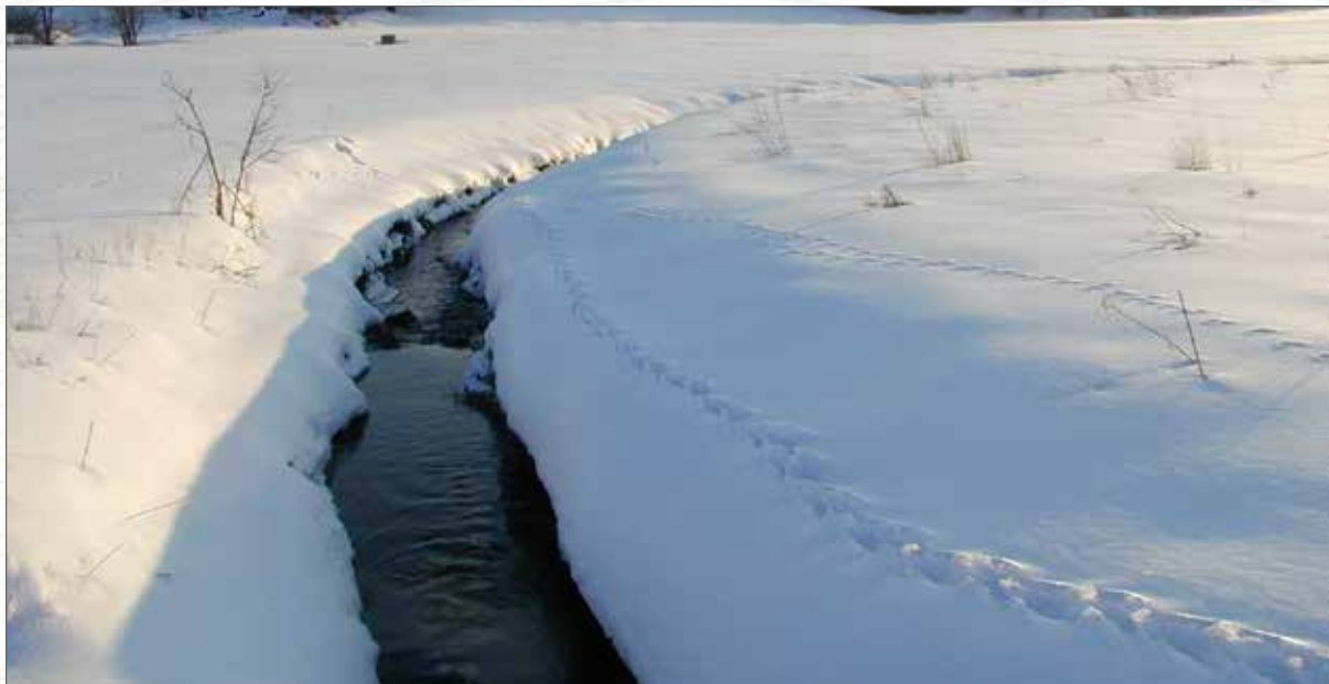
Obr. 194a. Stav koryta Zbytinského potoka v roce 2003 – napřímené rovné koryto zahloubené cca 1 m pod terén, celoplošně opevněné betonovými deskami.
