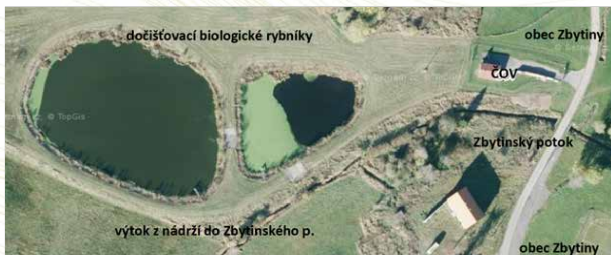
Obr. 188. Soustava čištění odpadních vod v obci Zbytiny s dočišťovacími rybníky. Zdroj: Mapy.cz, © Seznam.cz, a. s., © TopGis, s. r. o.
