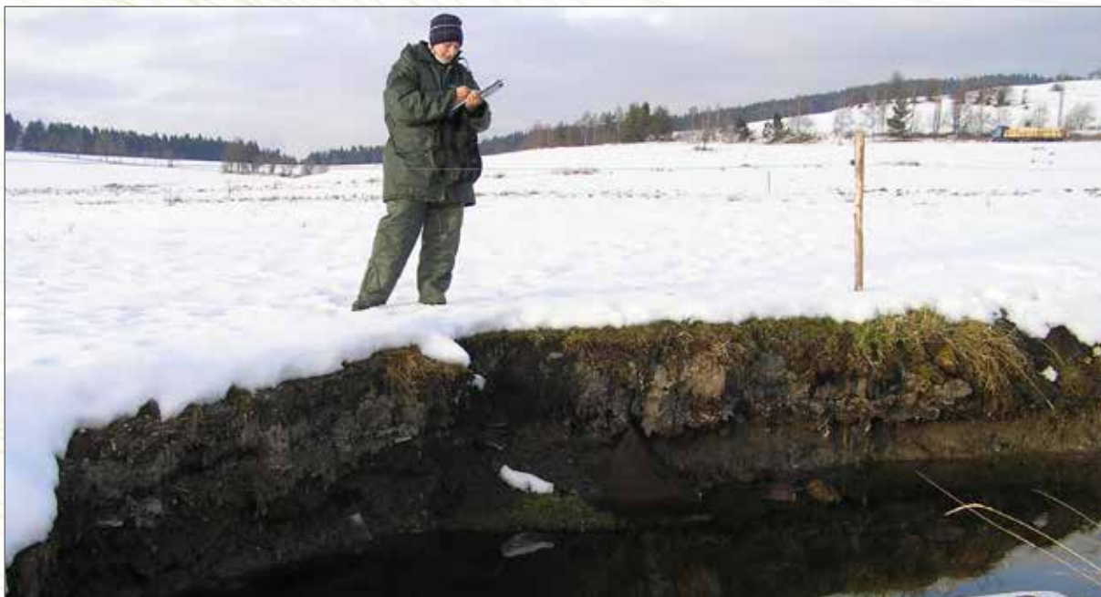
Obr. 196. Stav ohybu „D-a“ v prosinci 2005, kdy již byly zaznamenány masivní vnosy písku do hlavního toku Blanice. Jako řešení byly navrženy haťošterkové oživené válce.
