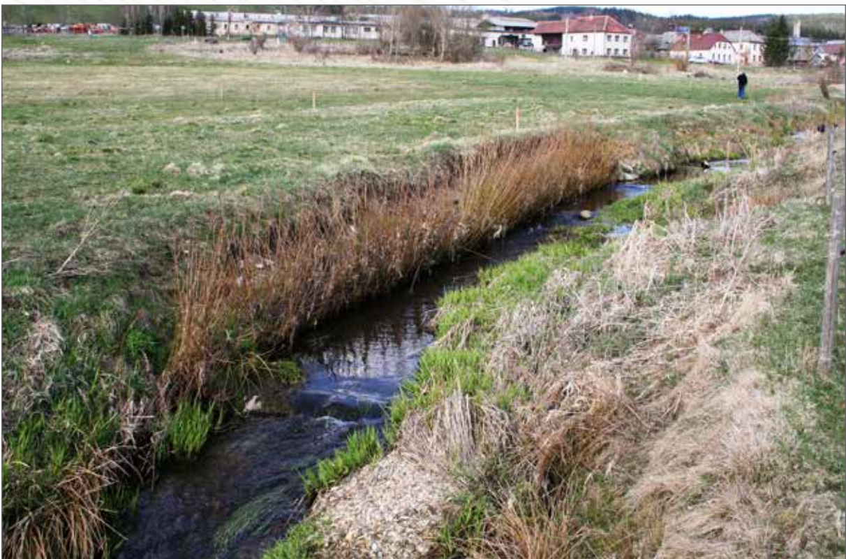
Obr. 150b. Zbytinský potok, Zbytiny – zpevnění erodujícího koryta hačošterkovým válcem. Obrostlý hačošterkový válec po první vegetační sezóně (podrobněji viz Příloha 23).
