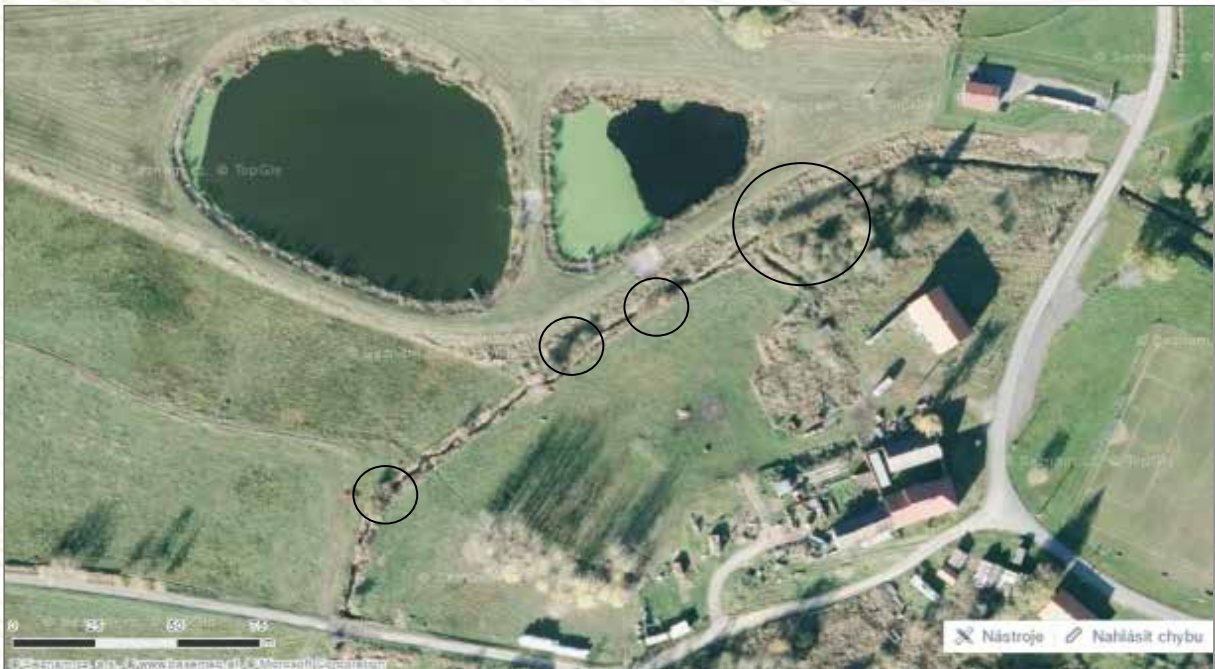
Obr. 201. Pohled na současný stav (v roce 2017) obrostlých haťošterkových válců (v černých kroužcích). Zdroj: Mapy.cz, © Seznam.cz, a. s., © TopGis, s. r. o.
