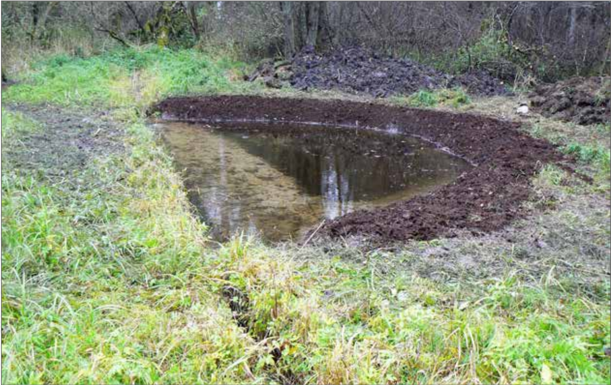
Obr. 163a. Příklad boční tůň. Průtočná tůň v povodí Zlatého potoka (ZORP) s kombinovanou funkcí, budována jako experimentální – modelový objekt, na kterém měly být ověřovány její očekávané funkce. Tůň bezprostředně po vyhloubení v roce 2010.
