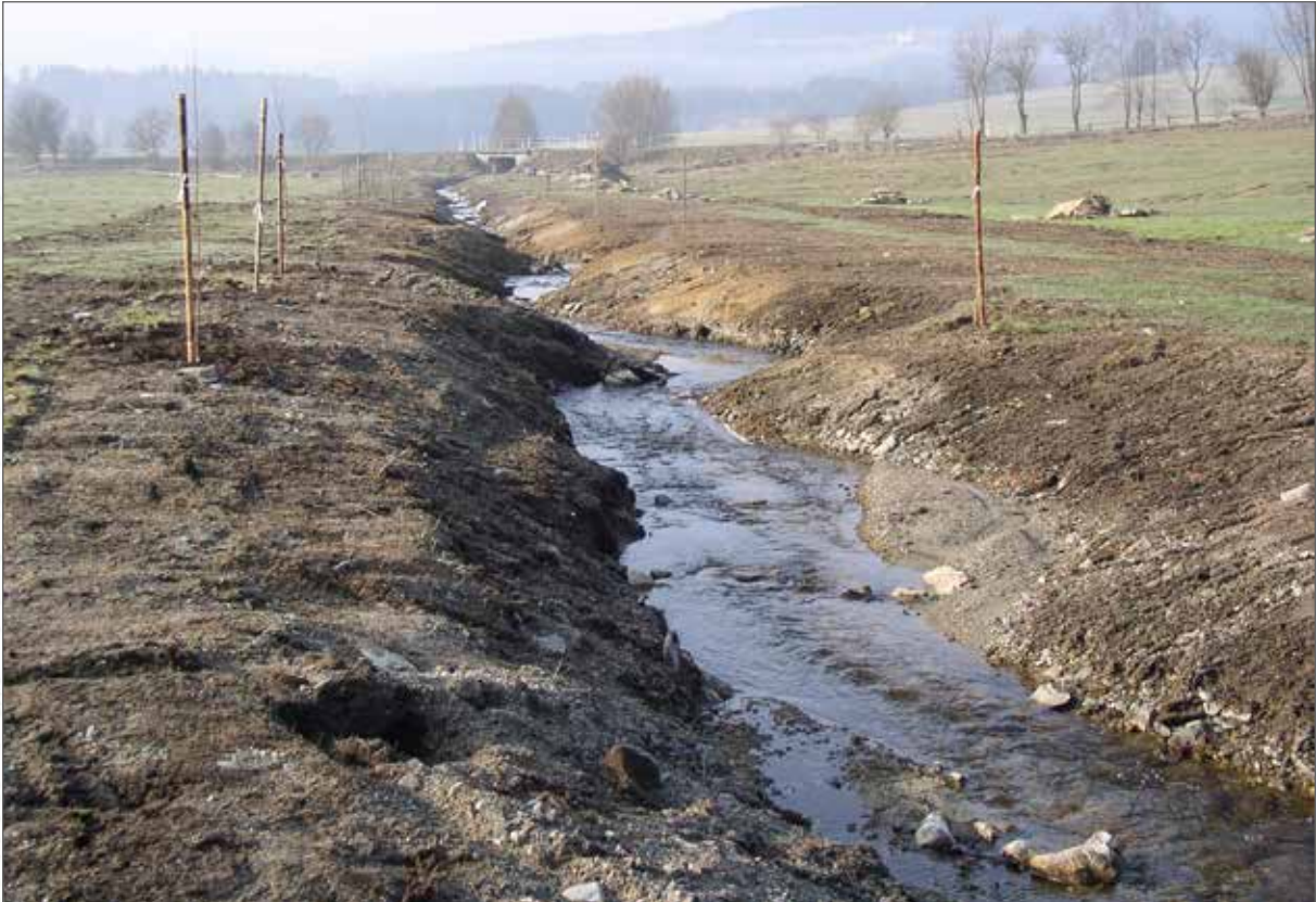
Obr. 151a. Průběh revitalizace na Zbytinském potoce. Vytrhání celoplošných panelů a ponechání nepřírodně zahloubeného koryta na podzim 2004 vedlo k nadměrnému vnosu splavenin do hlavního perlorodkového toku Blanice.
