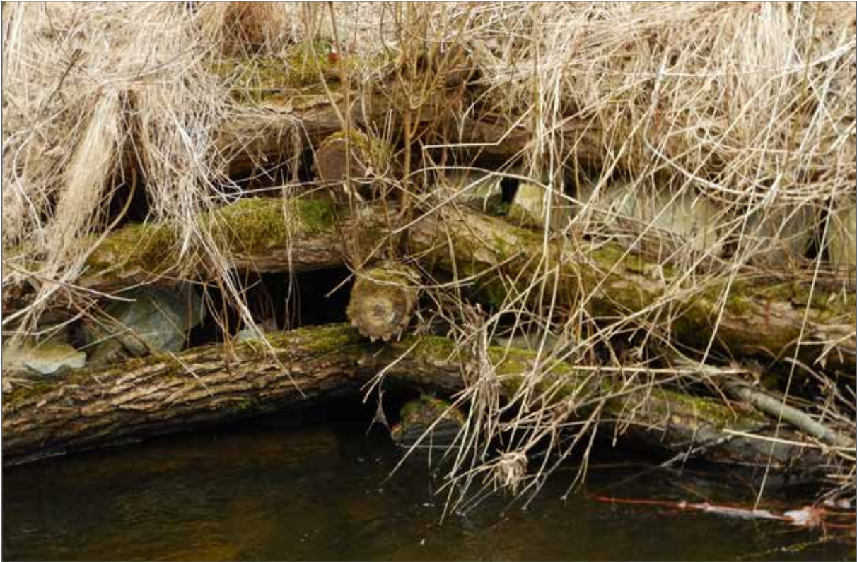
Obr. 154a. Živé srubové konstrukce z vrb. Detailní pohled na oživenou srubovou konstrukci z vrb v časném jaře – vrbové kmeny proložené lomovým kamenem.
