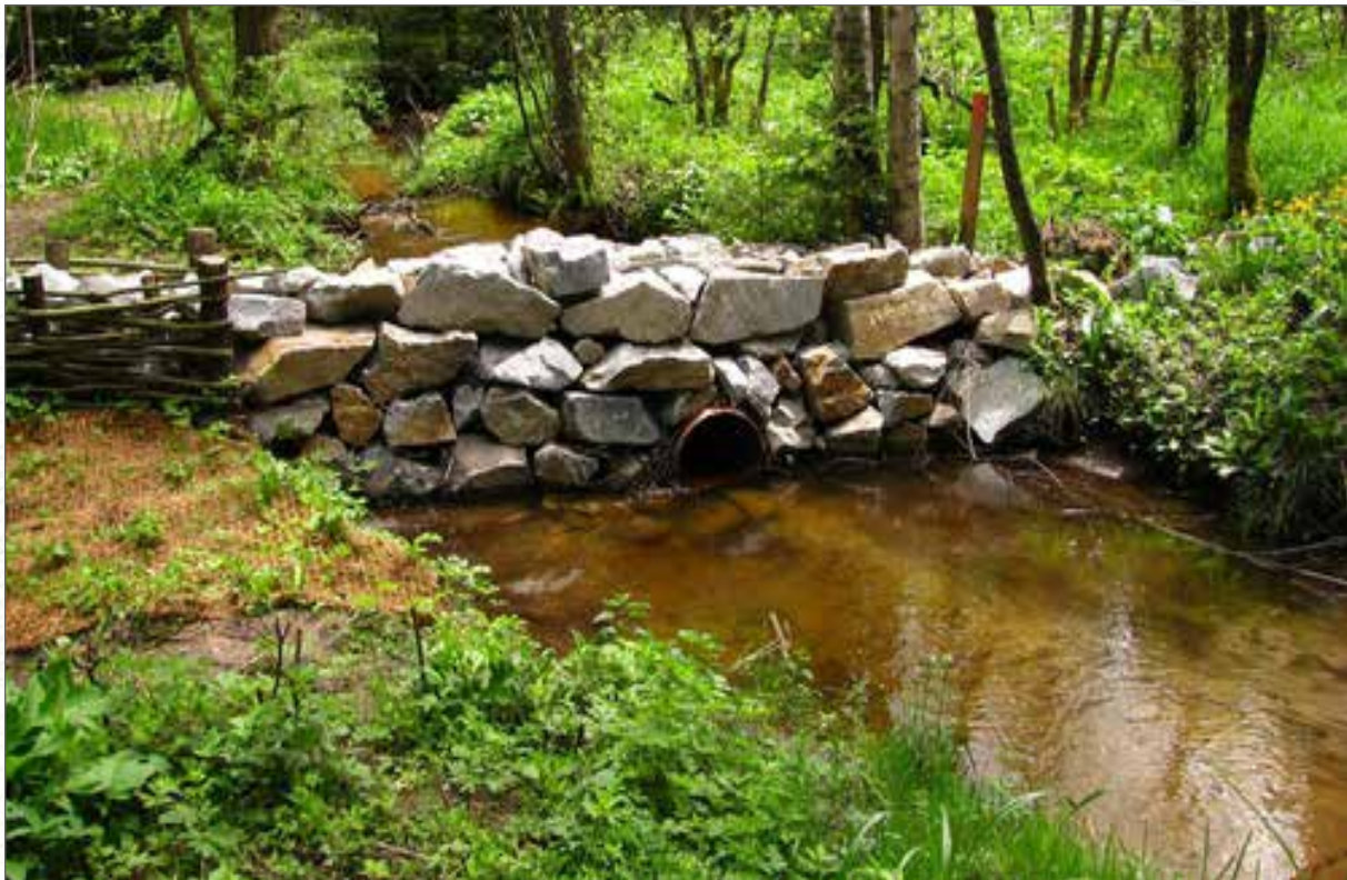
Obr. 147a. Technická realizace opatření na Lučním potoce v povodí Zlatého potoka. Rozliv těsně po dokončení stavby (zřetelná je plastová trubka převádějící celý běžný průtok a využití kokosových rohoží).
