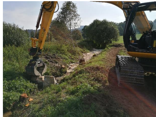
Obr. 31 Realizace kamenného skluzu
