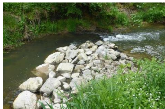
Obr. 33 Realizace kamenného výhonu
