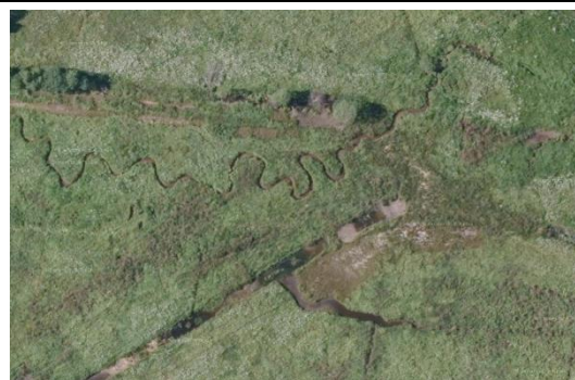
Obr. 29 Obnova přirozené trasy a zaslepení původního koryta
