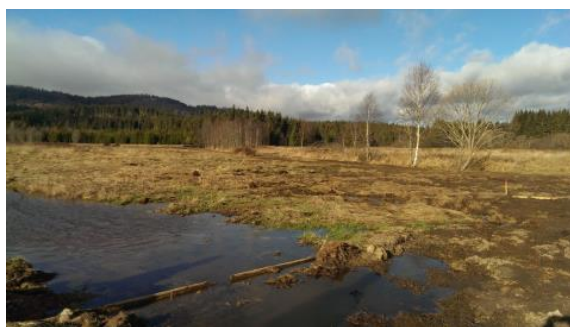
Obr. 28 Přehrazení odvodňovacího kanálu
