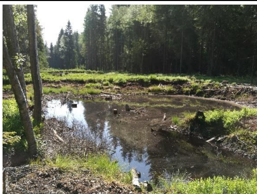
Obr. 36 Přehrazení hlavního odvodňovacího kanálu
