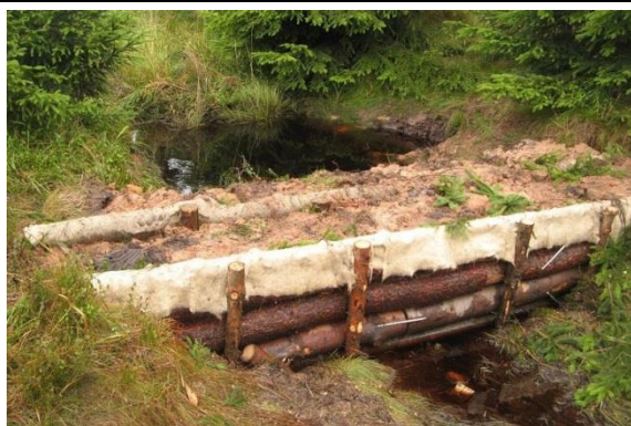
Obr. 32 Dvojitá těsněná srubová přehrážka
