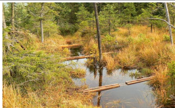
Obr. 38 Realizované přehrážky PR Klečové louky
