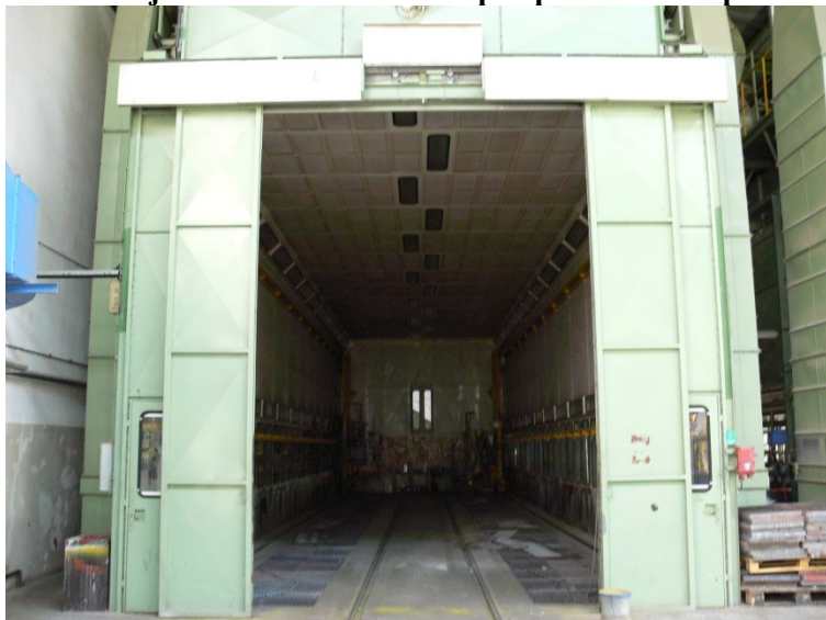
Obr. 6: Pojezdová stříkací kabina pro povrchovou úpravu kolejových vozidel
