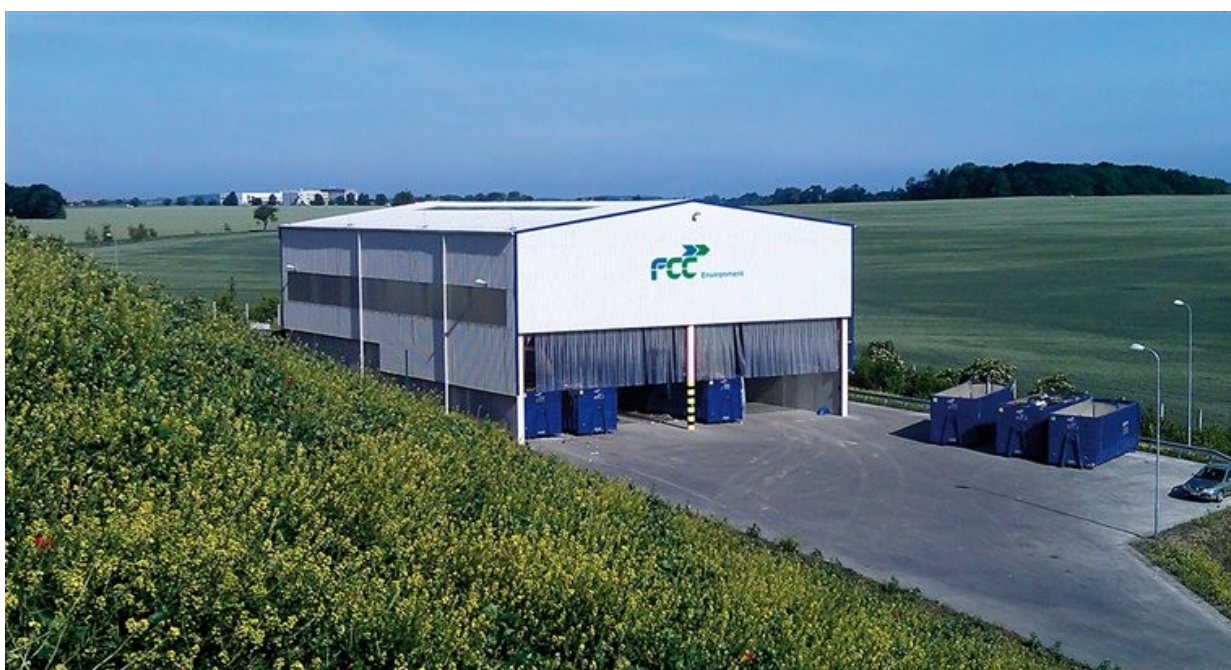
Obr. 4.: Překladiště halového typu
