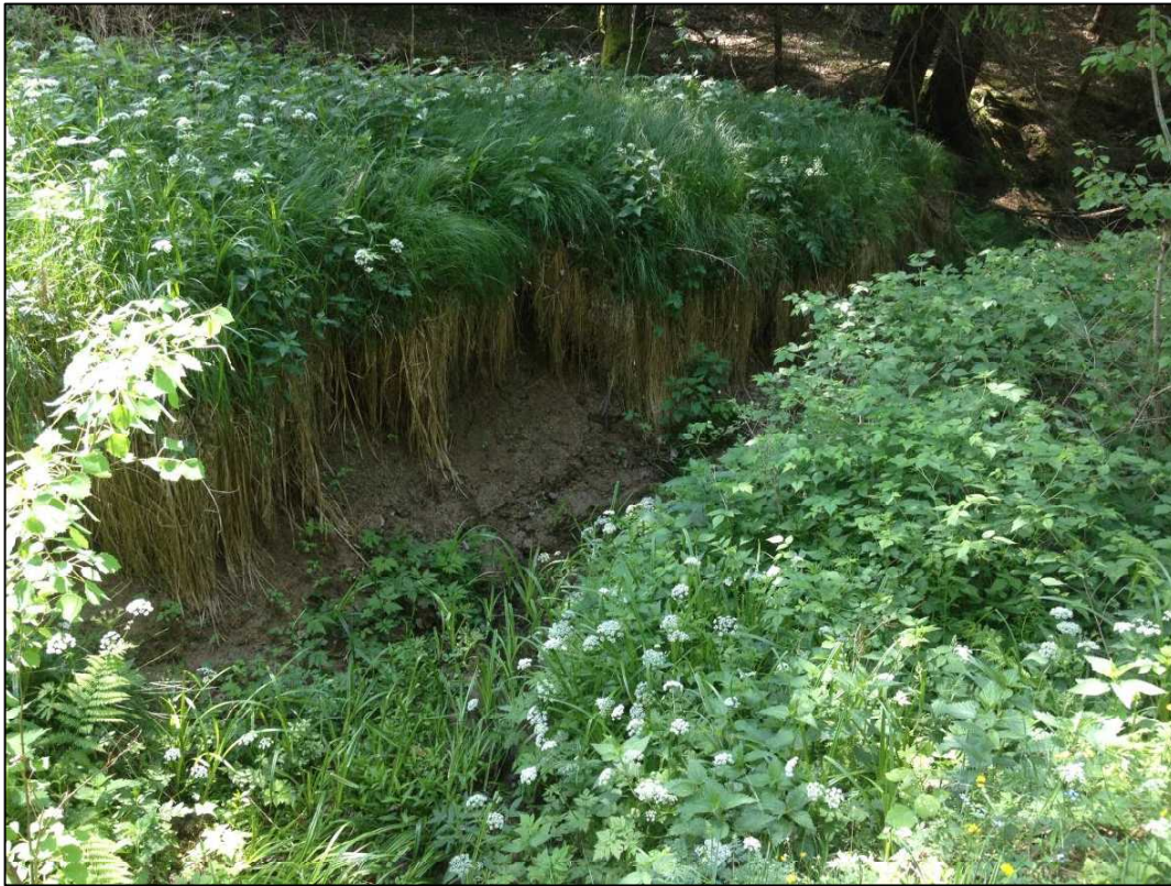
Břehová eroze na Vrážském potoce a ruderalizace okrajů (dílčí plocha 2c)
